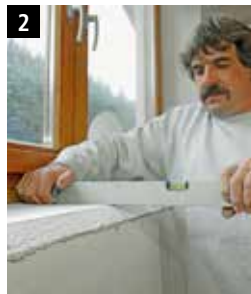
2 Incollare il materiale isolante resistente alla compressione (Sto-Sockelplatte PS 30 SE) su tutta la superficie con StoLevel In Mineral.
