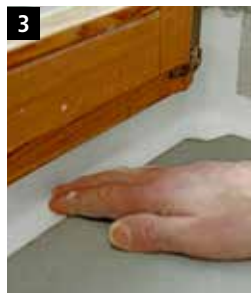
3 L'isolante e telaio della finestra compreso intradosso si esegue con StoSeal Band BK. In seguito è possibile riposizionare il davanzale.
