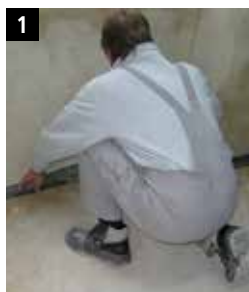
Incollaggio di Sto-Sidings-Profilband.
